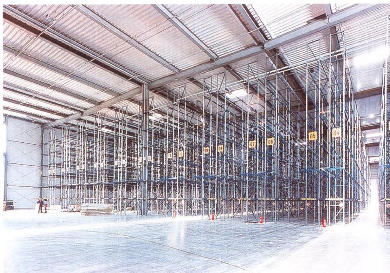
Das Hochregallager hat eine beheizte Bodenplatte aus Stahlbeton mit fugenlos aufgebrachtem Estrich erhalten Fotos: Velta, Norderstedt
